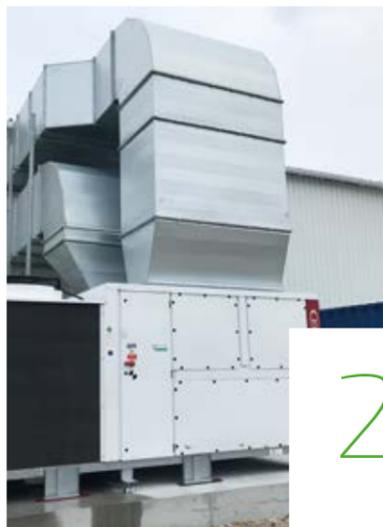
Fin 2019, le chauffage au fuel du magasin a été remplacé par une pompe à chaleur. Le système de régulation permet d'ajuster la température lorsque le bâtiment est inoccupé. Cette installation complète les travaux d'isolation du bâtiment réalisés ces dernières années.
